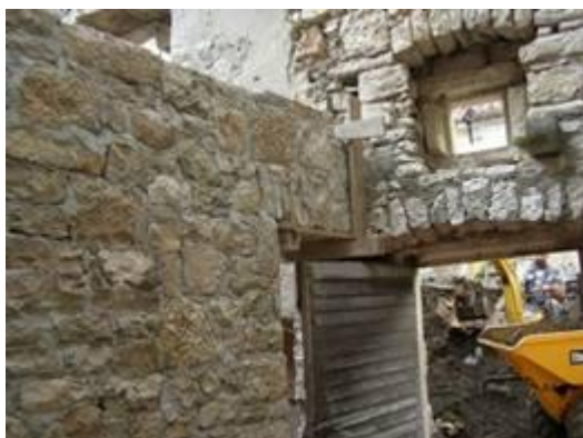
Restauro della Casa di Marco Polo a Korčula
